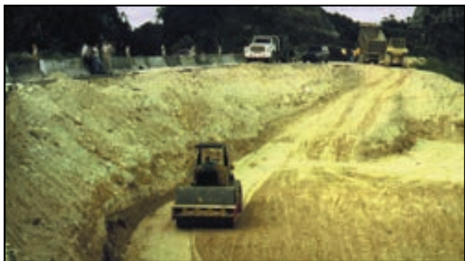
Foto 61. Actividades de mantenimiento en la carretera PR 10. La carretera se había inaugurado oficialmente al momento de tomar esta foto. Los constantes derrumbes auguran que este nivel de mantenimiento nunca se aminorará en este segmento de carretera. Foto de L. Miranda Castro.
