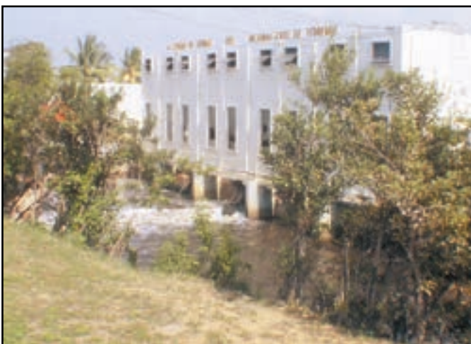
Foto 19. Casa de bombas en Caño Tiburones, Arecibo, Puerto Rico. Foto de J. Colón.
